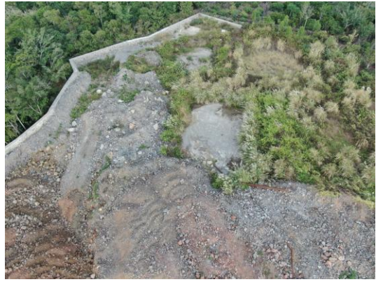
2#支洞堆渣场 (摄于 2020.3)
