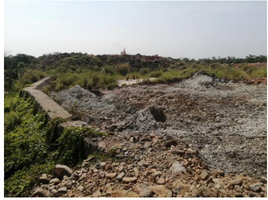
3#支洞堆渣场 (摄于 2021.6)
