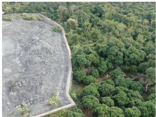
3#支洞堆渣场 (摄于 2020.3)
