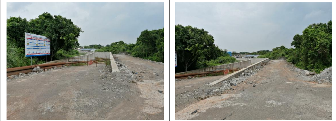
3#施工支洞 (攝于 2019.10)
