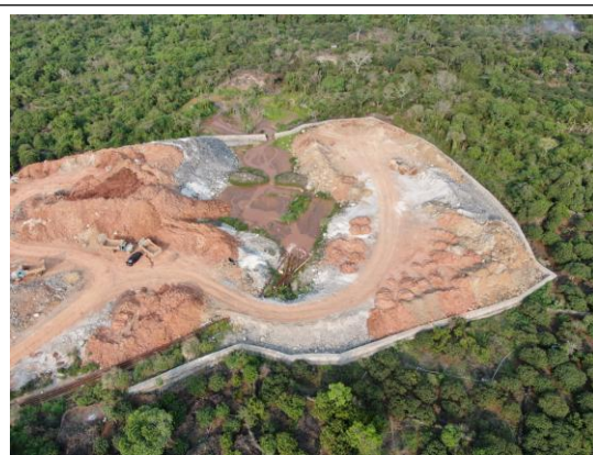
3#支洞堆渣场 (摄于 2020.9)
