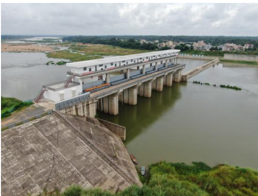
东山闸坝 (摄于 2021.3)
