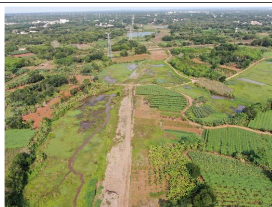
美安科技新城段管线 (摄于 2020.9)
