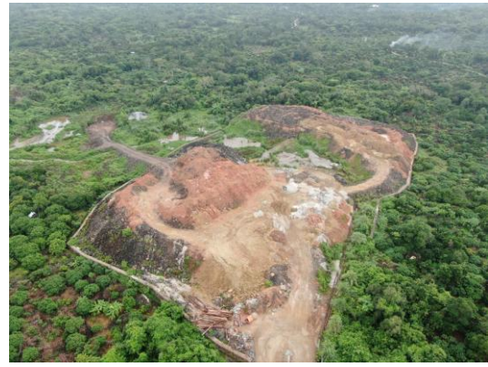
3#支洞堆渣场 (摄于 2020.12)
