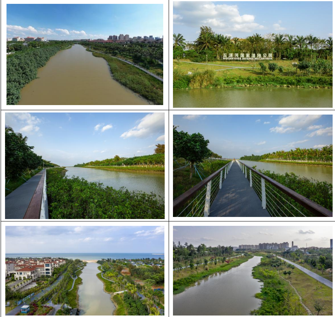
五源河整治工程现状照片
