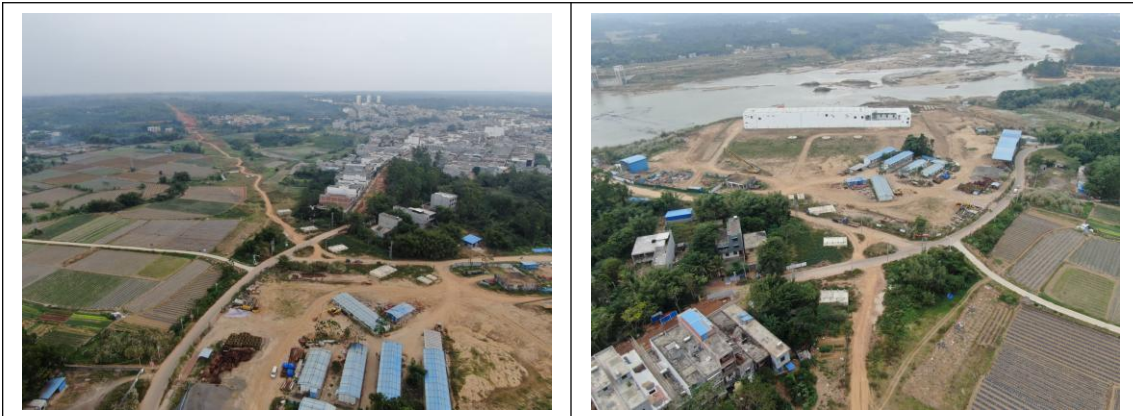
东山闸坝施工营地 (摄于 2020.3)
