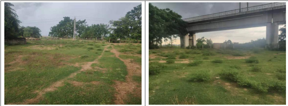
东部城市供水管线现状照片
