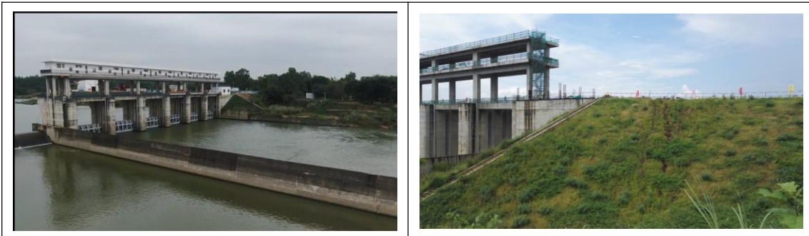
东山闸坝现状照片
