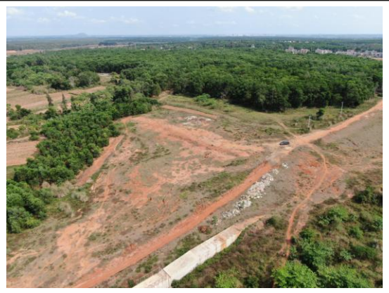
箱涵堆渣场 (摄于 2020.9)
