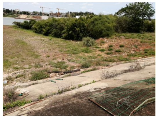
龙塘泵站堆渣场 (摄于 2020.9)
