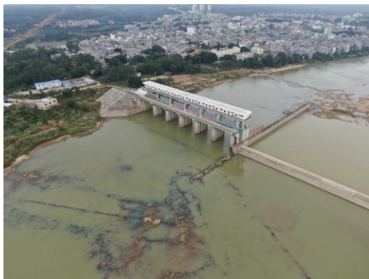
东山闸坝 (摄于 2020.3)
