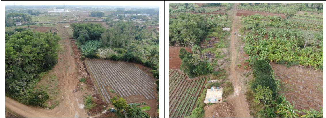
美安科技新城段管线 (摄于 2020.6)
