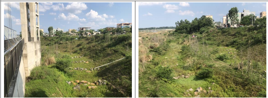
鱼道工程现状照片
