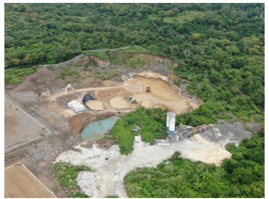
2#支洞堆渣场 (摄于 2020.12)
