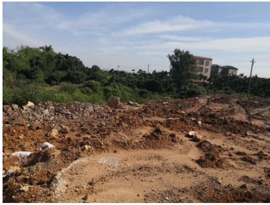
新增 4#支洞堆土场
