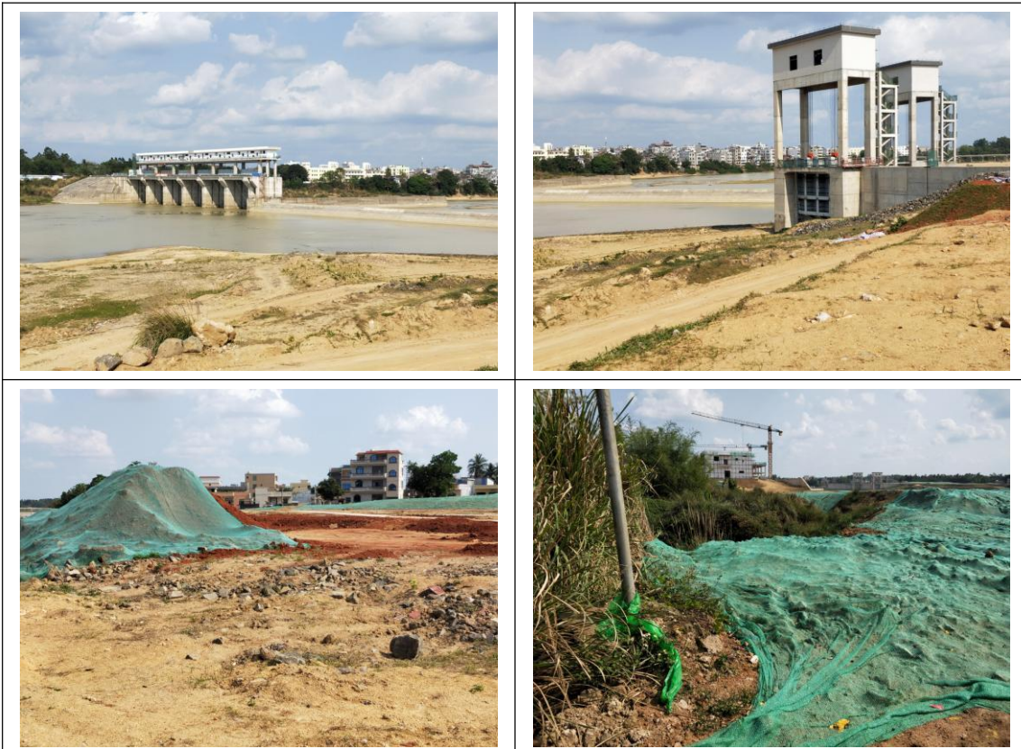
东山闸坝 (摄于 2018.8)
