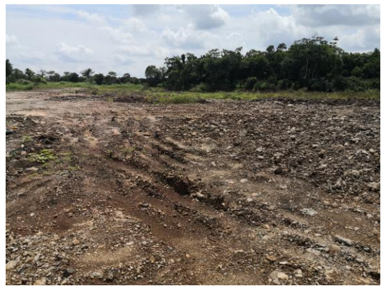
新增 3#支洞堆土场
