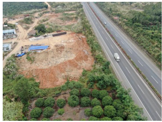
新增 4#支洞堆渣场 (摄于 2020.6)
