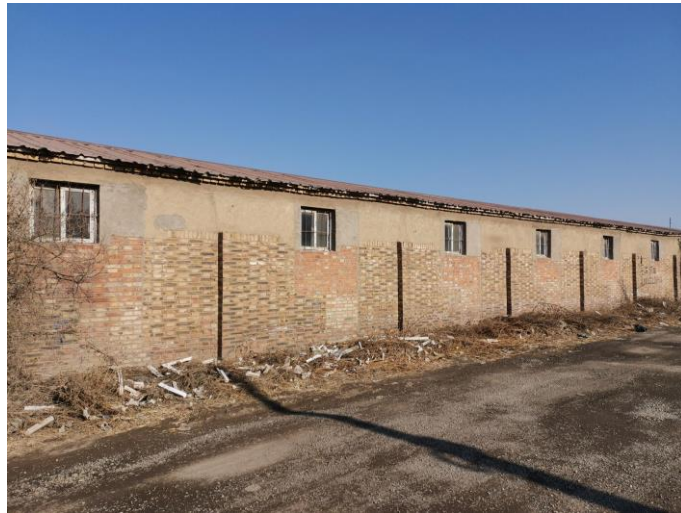
天津市兴生辉锌制品有限公司厂房
