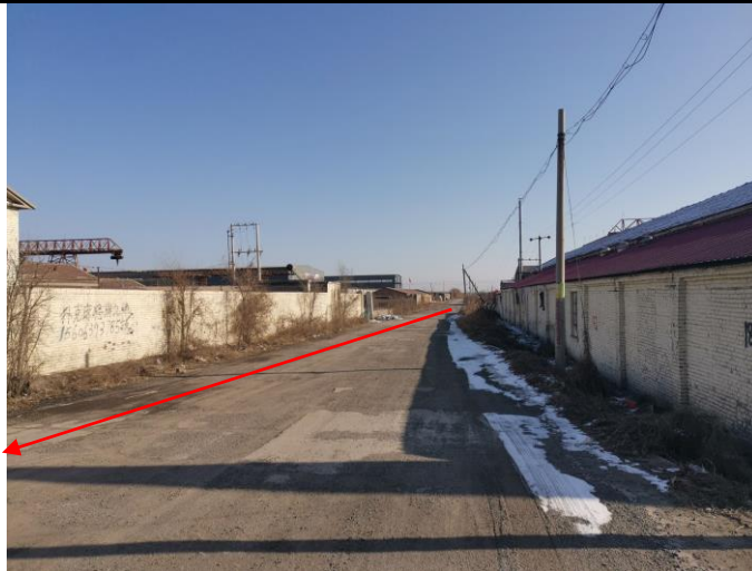
G46 与 G47 塔基之间电缆敷设段（道路，拉管敷设）
