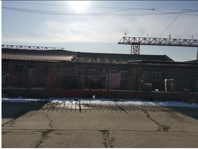
天津恒德益钢管有限公司员工宿舍
